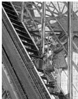
Escalier du sol au 1 er étage le long duquel est établi le manomètre. TTT, tubes de verre verticaux fixés au tube manométrique. Gravure de Louis Poyet (1846-1913) dans Travaux scientifiques exécutés à la tour de 300 mètres, de 1889 à 1900 , Gustave Eiffel, Paris, L. Maretheux, 1900.
